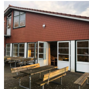
Außenansicht Raum im Feuerwehrhaus
