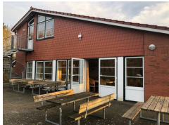
Außenansicht Raum im Feuerwehrhaus
